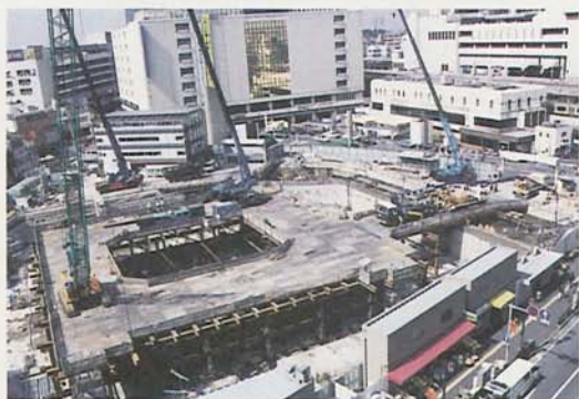
地下工事のために仮設していた鉄骨やコンクリートを取り払う
