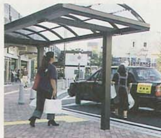
◀点字ブロックを敷き、段差をなくしたタクシー乗り場
