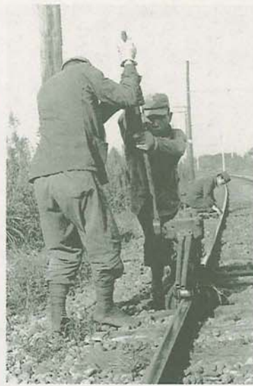
保線作業 (昭和38年11月 伊藤さん撮影)
