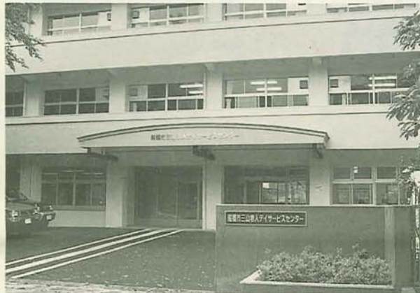
6月にオープンした三山デイサービスセンター(写真)をはじめ、ケア・リハビリセンターや清掃車などは、厚生年金・国民年金の積立金還元融資を受けて整備されました
