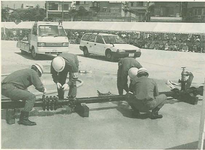
破裂した水道管の復旧作業訓練
