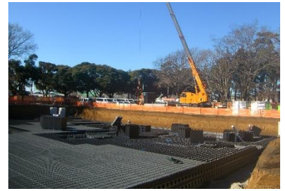
雨水貯留槽の設置 (高根木戸近隣公園)
