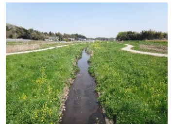
木戸川の多自然川づくり
