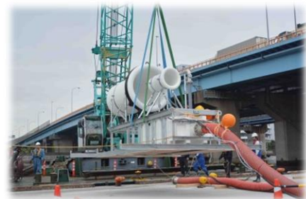
ジェット噴射で海の中をかき混ぜて青潮を軽減する「マルチストリーマー」
