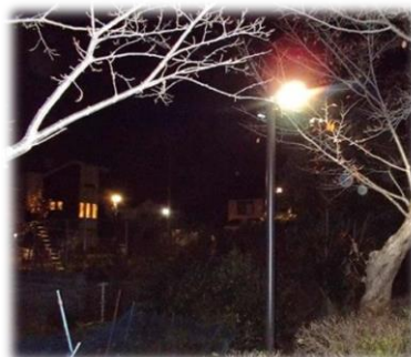
新たに設置された道路街路灯
