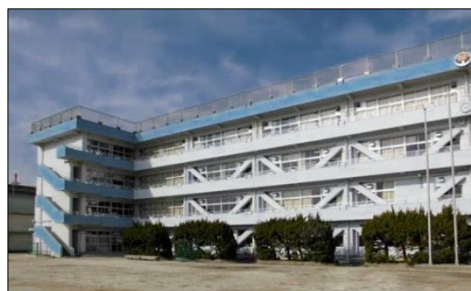
▲ 耐震改修が完了した湊町小学校
