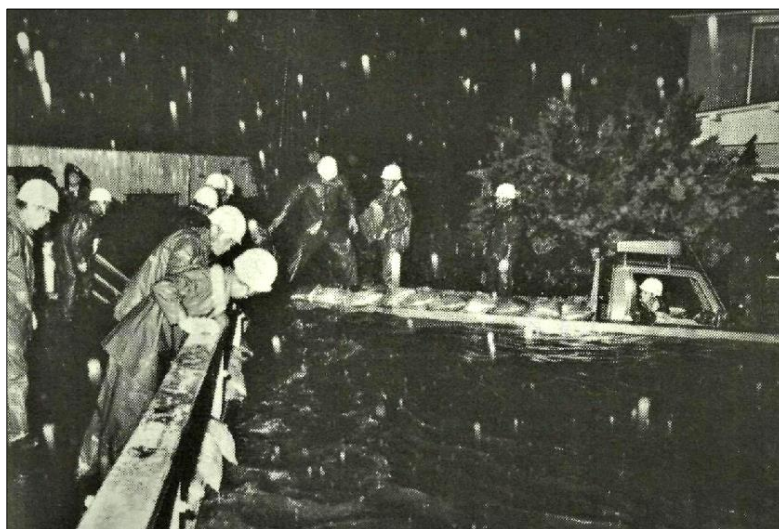
▲ 昭和61年8月、台風第10号による大雨で増水した海老川。 被害を最小限に食い止めるため、夜を徹して作業が続けられた。 (出典:広報ふなばし 昭和61年9月15日号)
