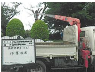
（伐採作業状況）
