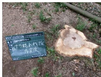
（伐採後の状況）
