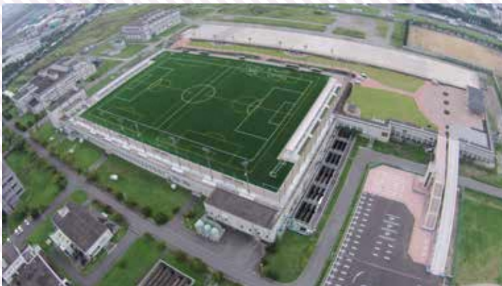
高瀬下水処理場上部運動広場「タカスポ」
