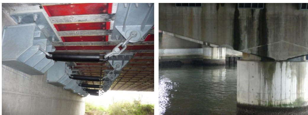
（図Ⅳ－1）新港大橋（下り線）の耐震補強工事
