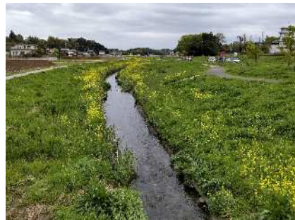
多自然川づくり
