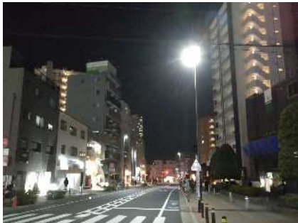
街路灯の設置
