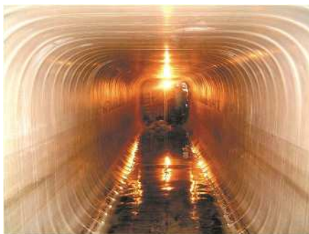
下水道管の耐震化
