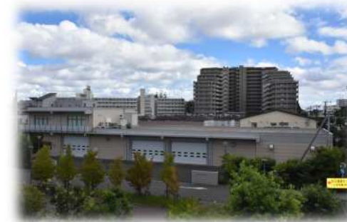
防災備蓄センター 【平成 27 (2015) 年運用開始】
