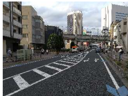
電線類の地中化
