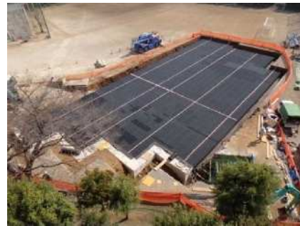
貯留浸透施設の整備
