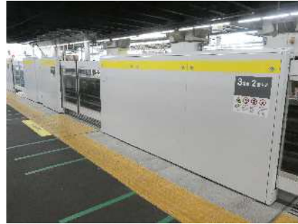
ホームドアの設置
