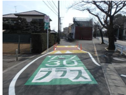
「ゾーン 30 プラス」の整備
