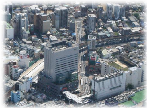
奥側の線路：高架化された京成本線 【平成 18 (2006) 年完全高架化】 中央の道路：都市計画道路 3・4・11 号線 【平成 29 (2017) 年開通】
