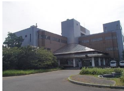
公共下水道の整備
