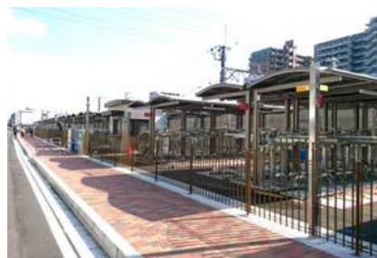
駐輪場の整備
