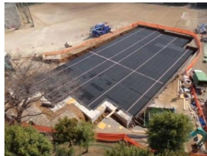
貯留浸透施設の整備
