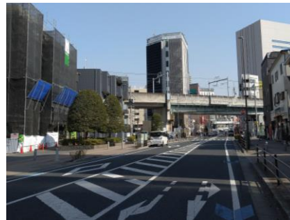
電線類の地中化
