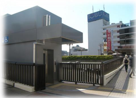
JR 船橋駅北口広場エレベーター 【平成 28 (2016) 年設置】
