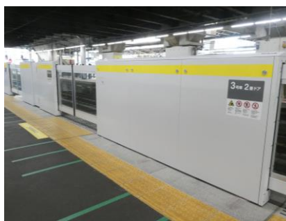
ホームドアの設置
