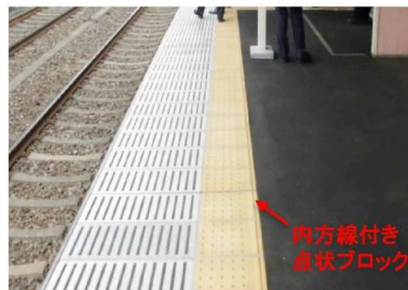
内方線付き点状ブロック
