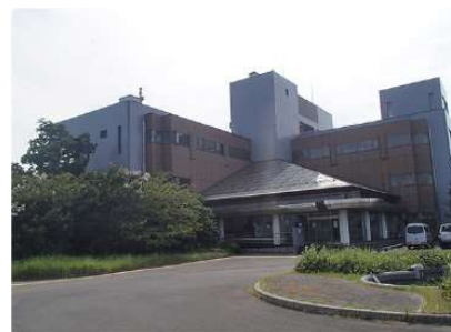
高瀬下水処理場
