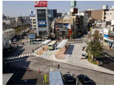
駅前広場の整備（西船橋北口広場）
