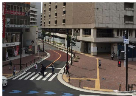
電線の地中化（船橋駅周辺）
