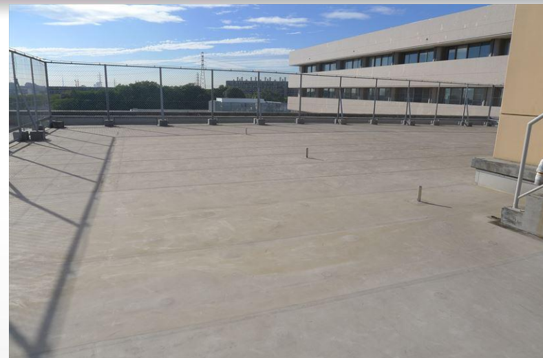
• 防水工事が行われた屋上
