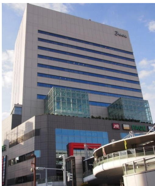
フェイスビル外観
