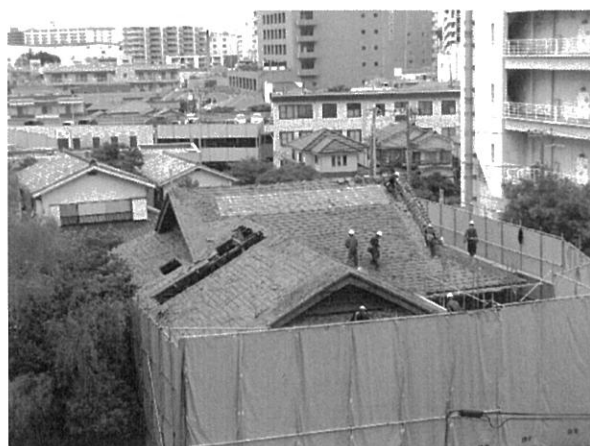
第二別館解体前に屋根瓦を下ろし作業
