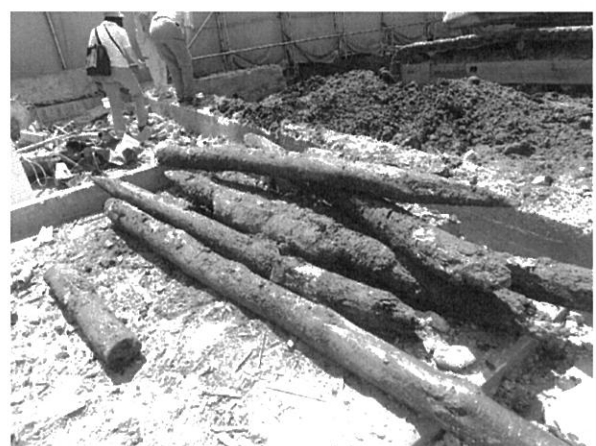
第二別館解体後 塩田跡に建てるため、地盤強化のために打ち込まれた松杭(長さ3.2m、直径18~20cm)
