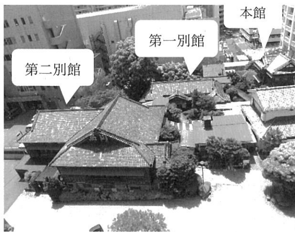
解体前「玉川旅館」 隣接ビルから撮影
