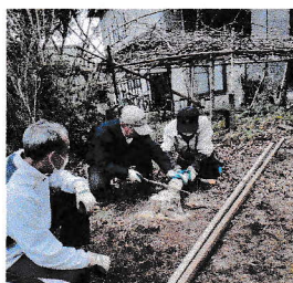
キウイ棚の修理
