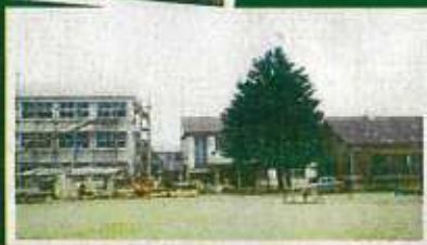
本舎から新築コンクリートへの校舎の建て替え 昭和42(1967)年
