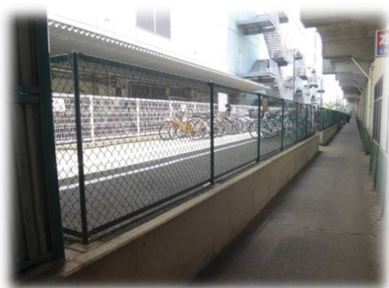
下総中山駅第 2 自転車等駐車場（増設）
