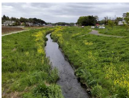
多自然川づくり
