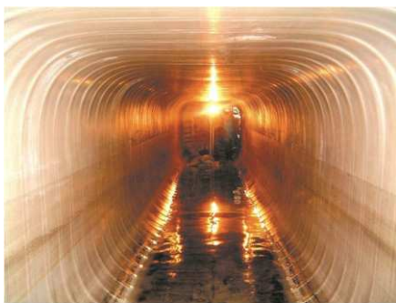
下水道管の耐震化
