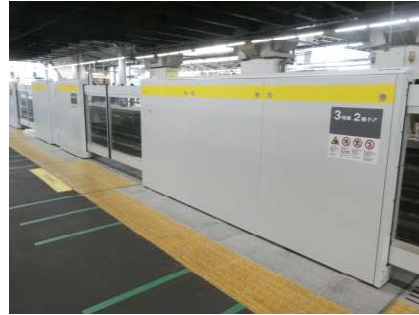
ホームドアの設置
