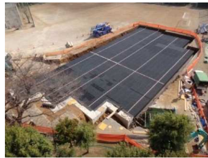
貯留浸透施設の整備
