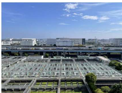
公共下水道の整備
