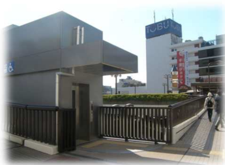
JR 船橋駅北口広場エレベーター 【平成 28（2016）年設置】
