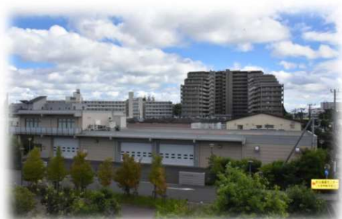
防災備蓄センター 【平成 27（2015）年運用開始】
