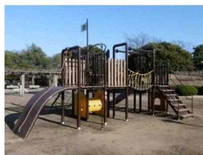
既存公園の改修
