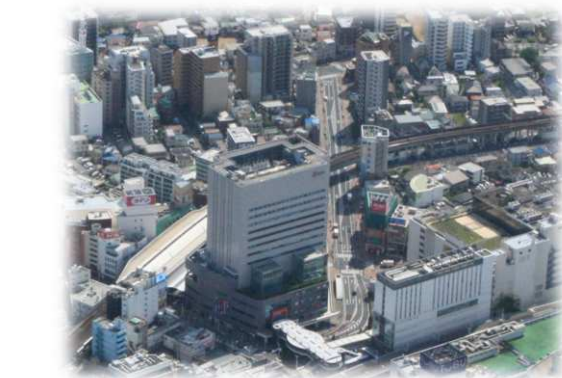
奥側の線路：高架化された京成本線 【平成18(2006)年完全高架化】 中央の道路：都市計画道路3・4・11号線 【平成29(2017)年開通】
