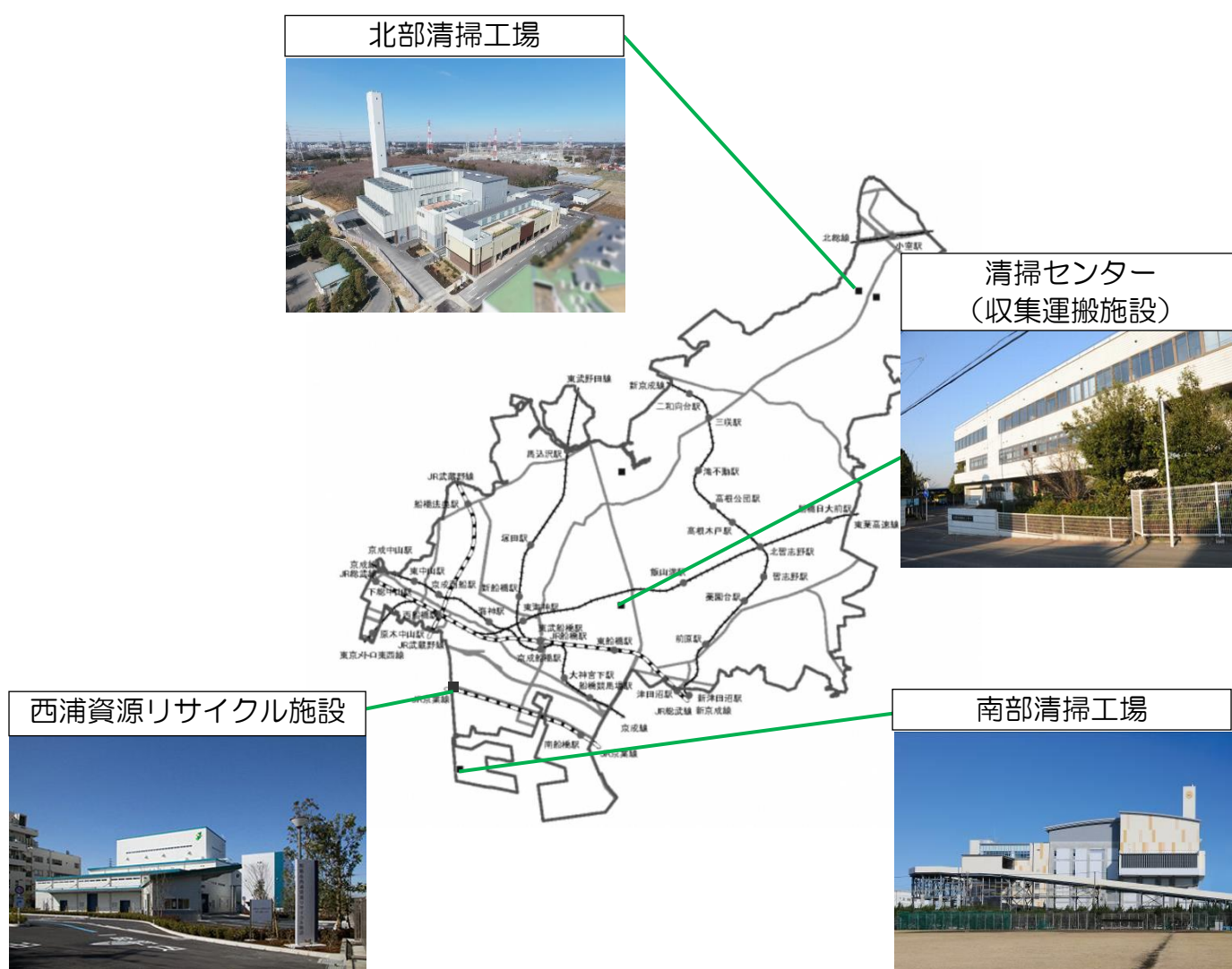
図2-1-2 本市の設置するごみ処理施設
