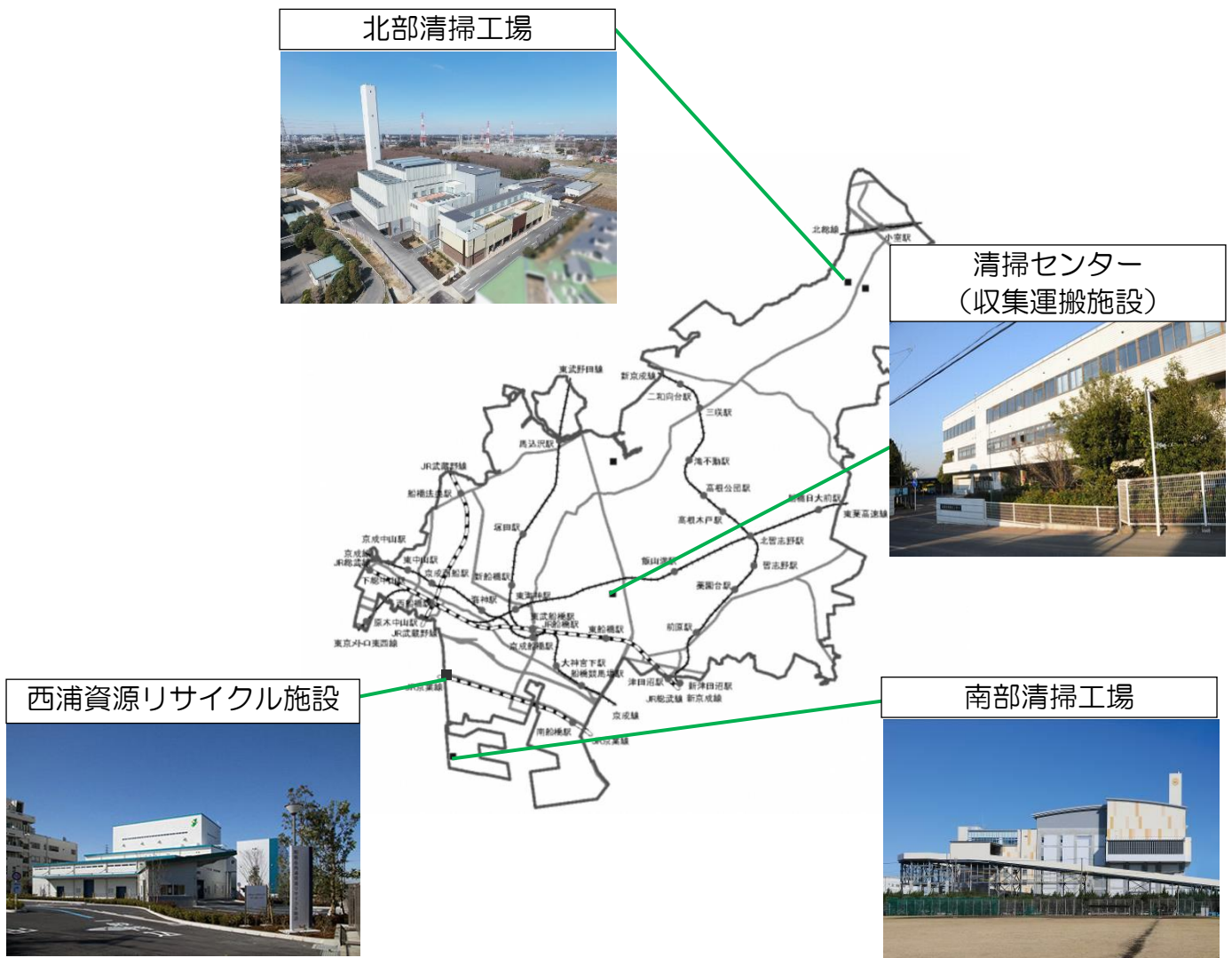
図2-1-2 本市の設置するごみ処理施設
