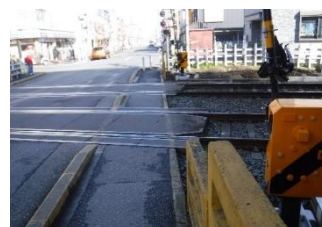
鎌ヶ谷大仏3号踏切現況
