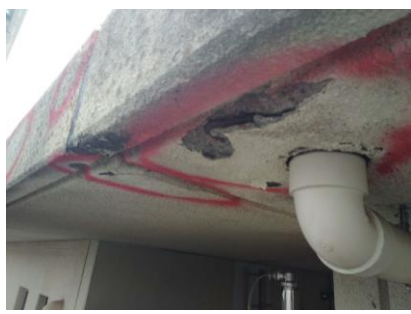
劣化調査 外壁の劣化した部分をマーキングし、調査します。
