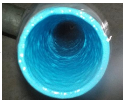
施工後 エポキシ塗料で塗装仕上げ
