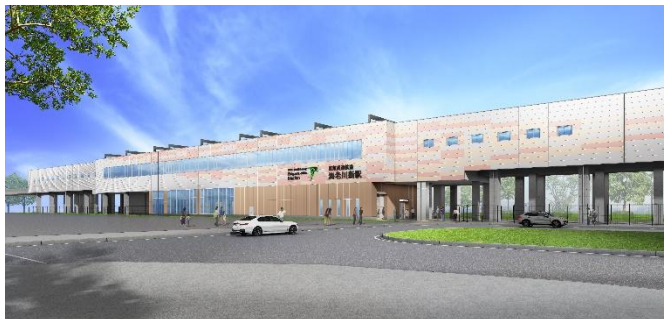
駅南側から駅舎を望む
