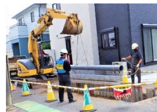
下水道管整備状況
