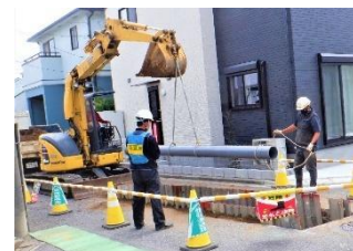
下水道管整備状況
