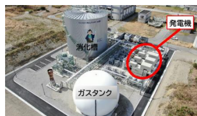
高瀬下水処理場
