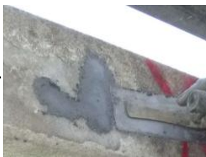
下地補修 劣化した部分を取り除き補修します。
