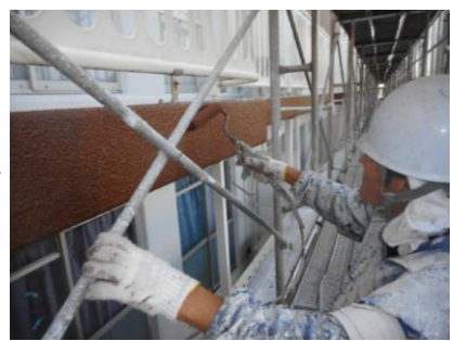
外壁塗装 防水性のある塗料を塗装します。
