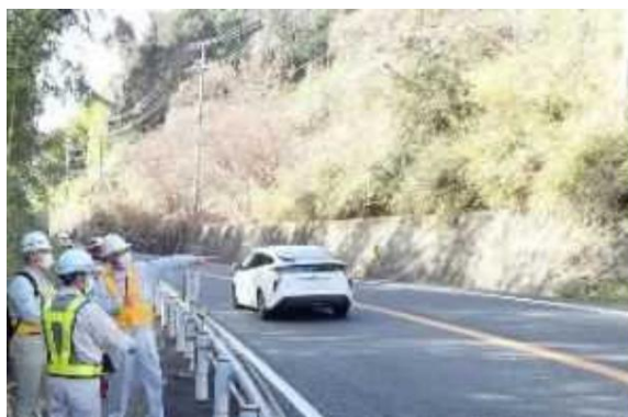
公道等からの現地確認のイメージ (国交省「盛土等の安全対策推進ガイドライン及び同解説」より)
