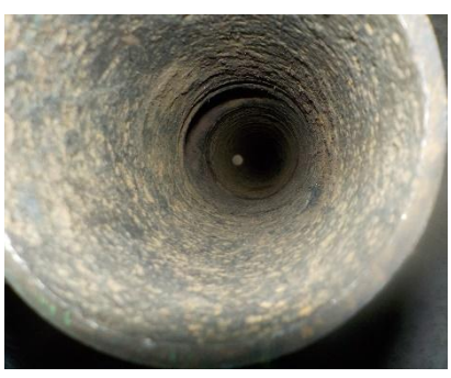
施工中 研磨し平滑になった排水管内面
