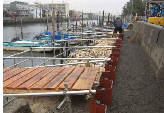
護岸仮復旧の状況 (令和5年3月)
