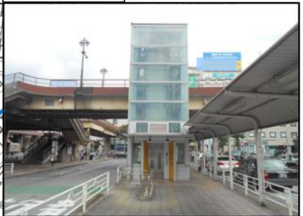
既設エレベーター
