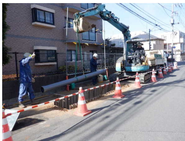
下水道管(污水)整備状況
