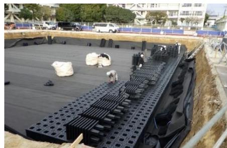
雨水貯留浸透施設施工例（高郷小学校）
