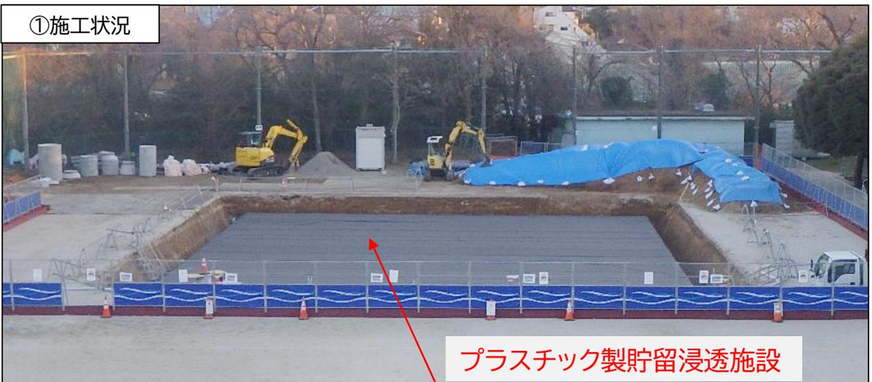
プラスチック製貯留浸透施設
