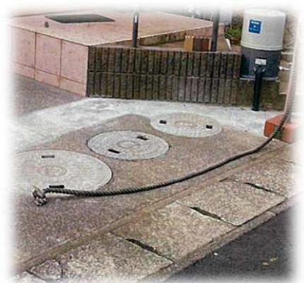
浄化槽転用貯留施設
