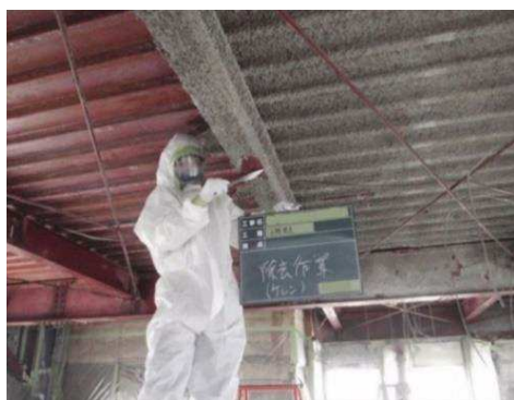
除去工事にてアスベスト を取り除く
