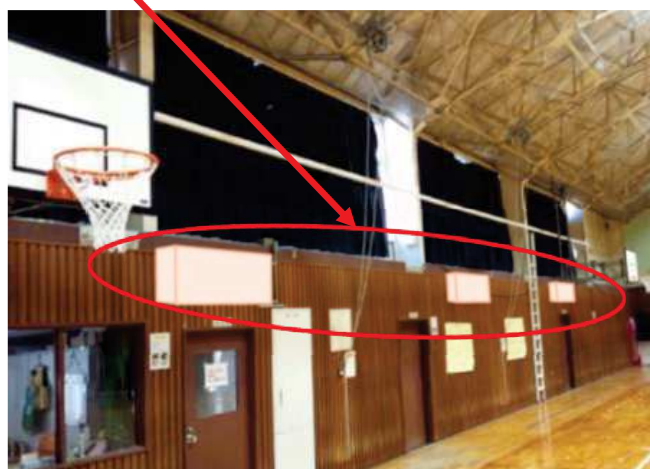
鉄骨造体育館
