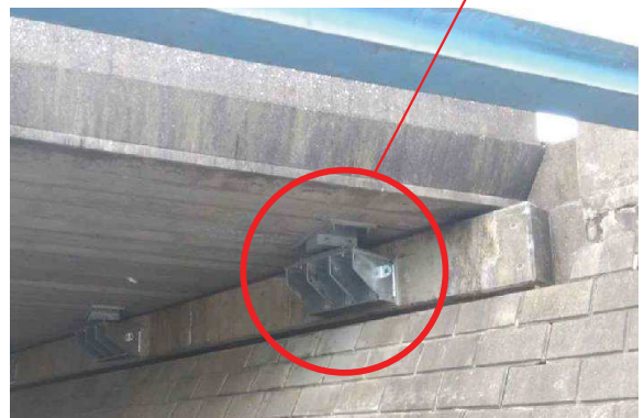
支承補完構造※2
