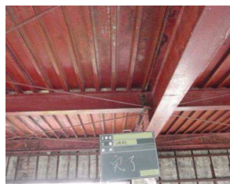
除去工事にてアスベスト を取り除く
