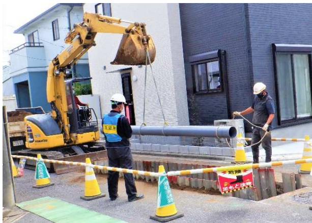
汚水管布設状況
