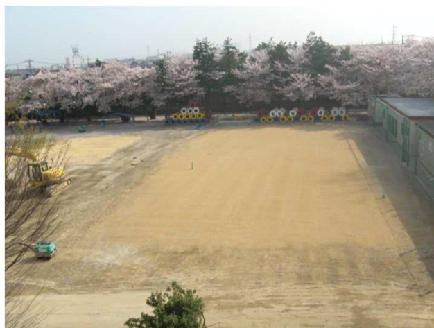
貯留浸透施設設置完了
