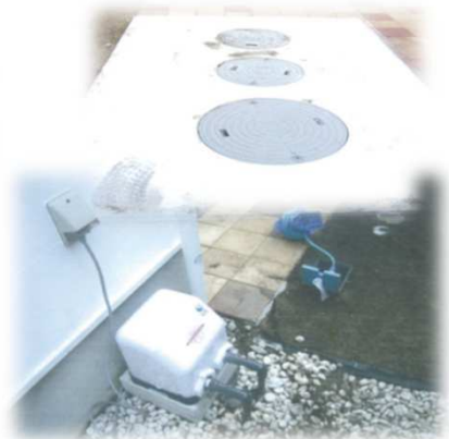
浄化槽転用貯留施設
