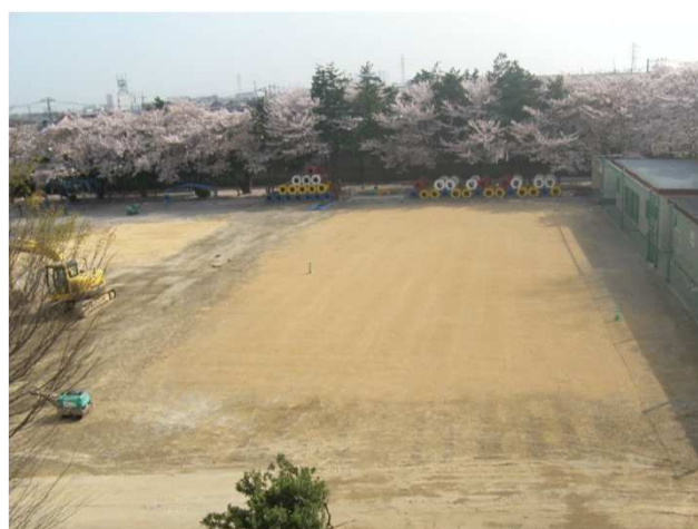
貯留浸透施設設置完了
