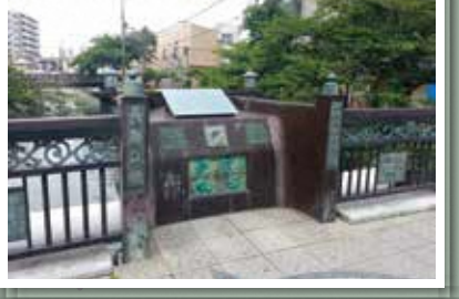
55 海老川13橋(海老川橋)
