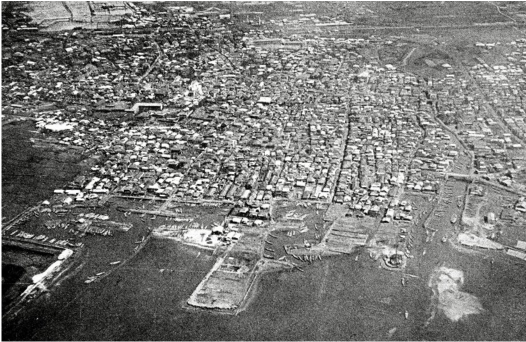
昭和初期（海老川河口と船だまり）
