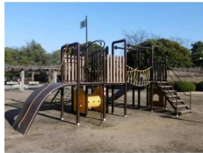
既存公園の改修
