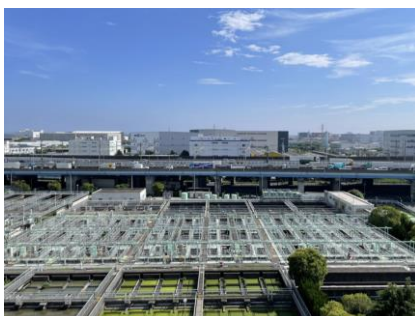
公共下水道の整備
