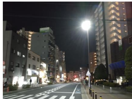
街路灯の設置
