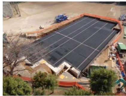
貯留浸透施設の整備
