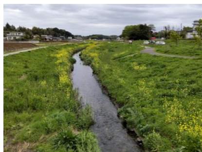
多自然川づくり
