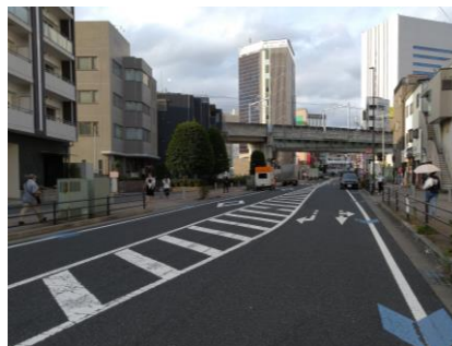
電線類の地中化
