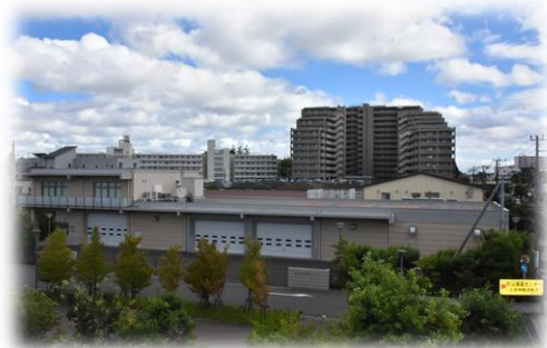
防災備蓄センター 【平成 27（2015）年運用開始】
