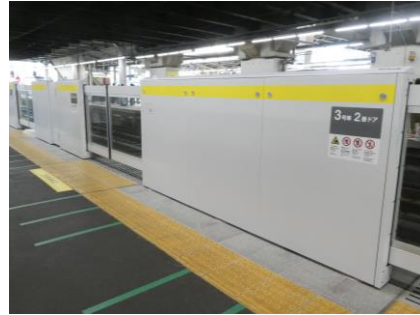
ホームドアの設置
