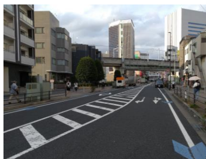
電線類の地中化
