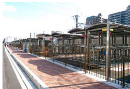
駐輪場の整備
