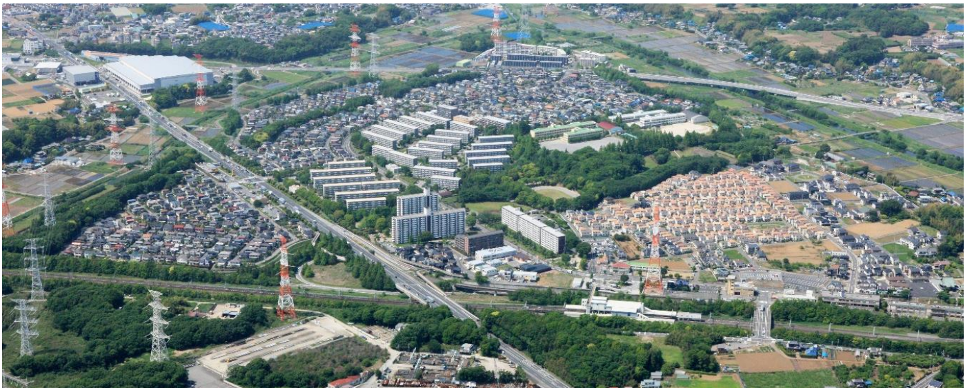
新住宅市街地開発事業(小室地区)
