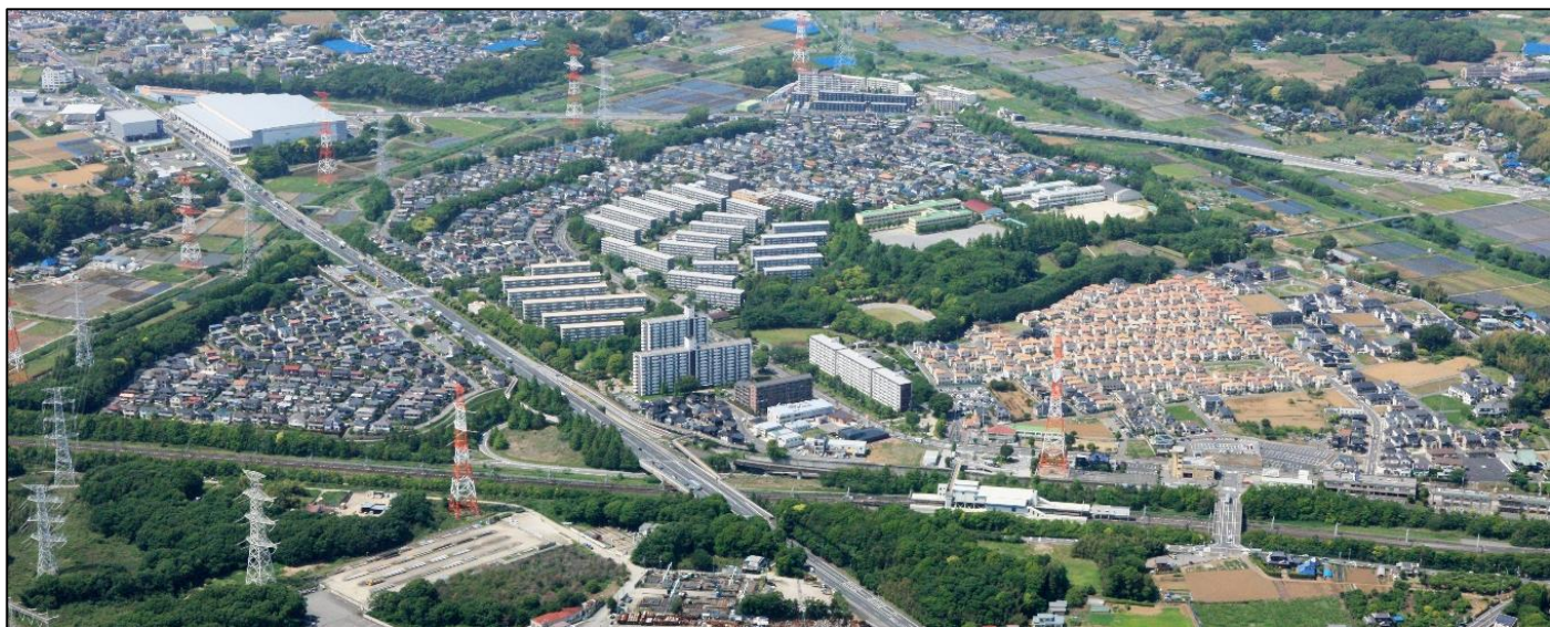
新住宅市街地開発事業(小室地区)
