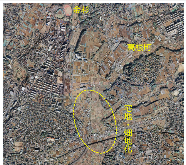
現在の状況（平成 27 年 12 月撮影）
