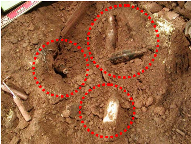
写真1 旧相模海軍工廠跡地内の工事現場から発見された旧軍の化学剤入りビール瓶の出土状況と発見されたビール瓶の一例 (写真提供: 国土交通省)
