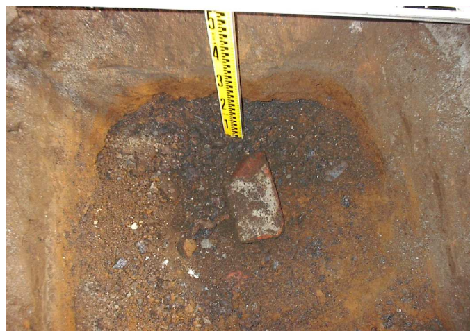
埋設物の例 レンガ
