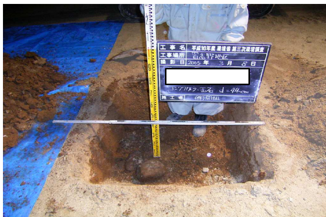
埋設物の例 玉石
