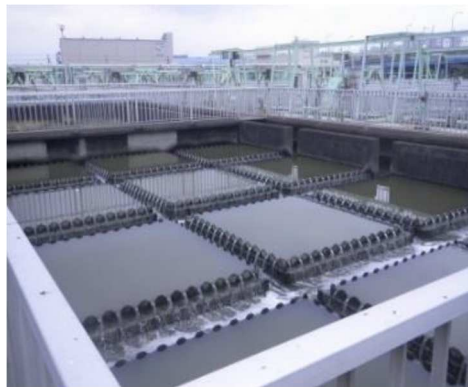
下水処理 (汚泥発生)
