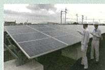
太陽光発電設備の検査の様子
