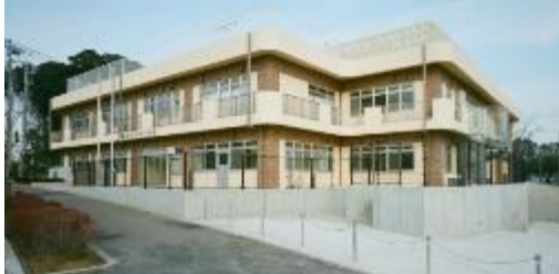
坪井公民館の太陽光発電システム
