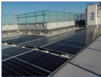
太陽光発電設備 (丸山小学校)
