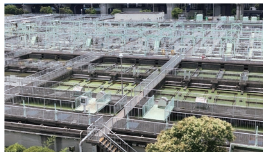
西浦下水処理場
