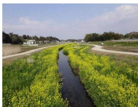
多自然川づくりによる河川改修 (木戸川)
