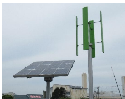
ふなばし三番瀬環境学習館に設置される風力発電設備と太陽光発電設備
