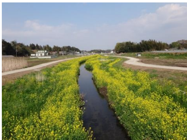
多自然川づくりにより整備された木戸川
