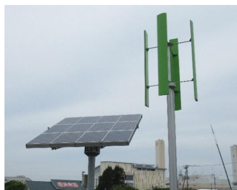
ふなばし三番瀬環境学習館に設置される風力発電設備と太陽光発電設備
